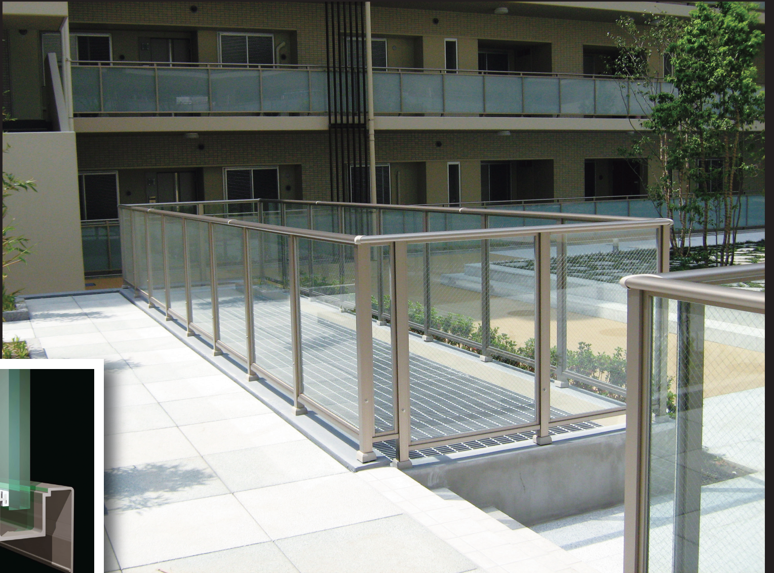
下枠ポケット幅 17mm (10mm 合わせガラスまで対応)
